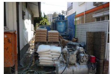
写真1 プラント設置
