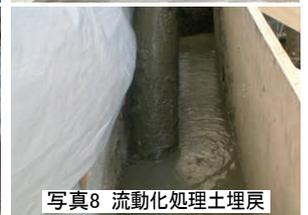
写真8 流動化処理土埋戻
