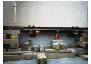
写真-4 ジャッキダウン据付け
