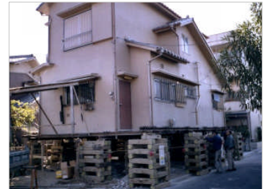
写真-2 ジャッキアップ嵩上げ
