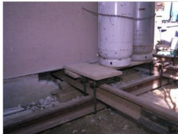
写真-1 根掘材の取り付け
