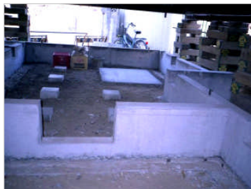
写真-3 基礎打ち替え
